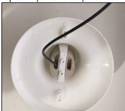
Figura 9 - Representação da introdução do cabo em um bocal.
