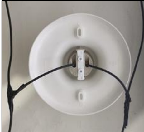
Figura 14 - Representação do isolamento do bocal em paralelo.
