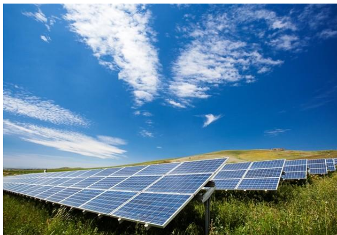
Figura 8: Painéis de energia solar.
