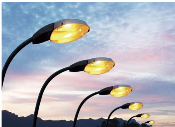
Figura 7 :Iluminação em vias acionadas por relé fotoelétrico.
