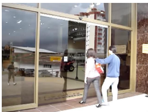
Figura 9: Porta de abertura automática
